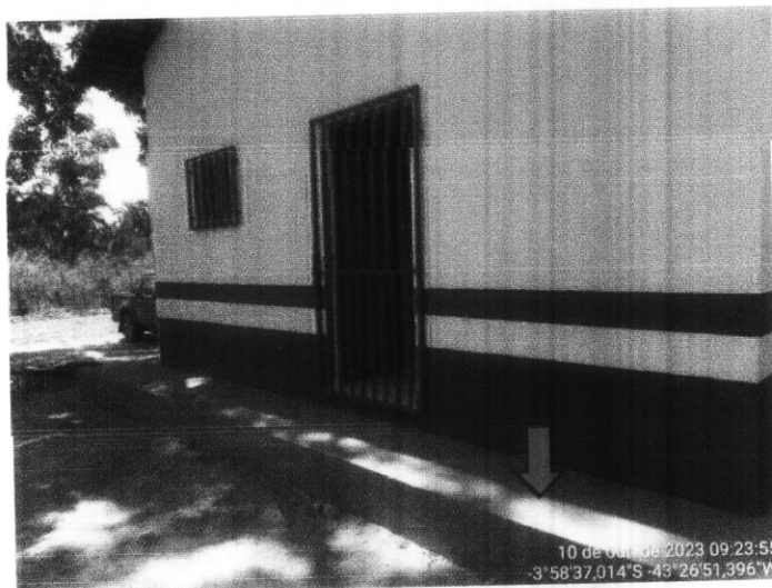
Imagem 04: pintura do piso (calçada)
